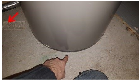
drain de plancher proximité du chauffe-eau
