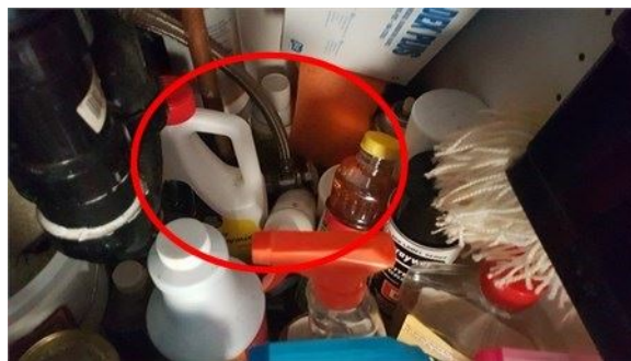
Les valves doivent être accessibles
