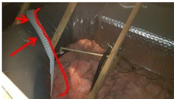
Gaine de ventilation à remplacer par une gaine rigide et isolé
