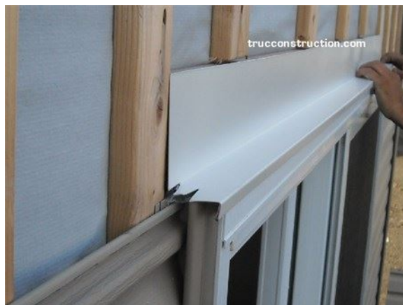
Voici à quoi devrait ressembler le solin au dessus de la fenêtre.
