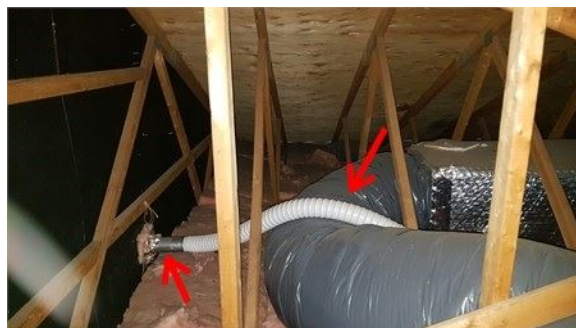
Conduit à remplacer, incluant l'émergence mural
