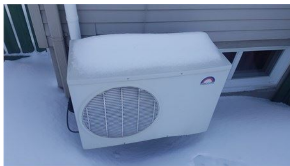
condenseur extérieur à protégé des intempéries et de la neige, ( prévoir un petit toit)
