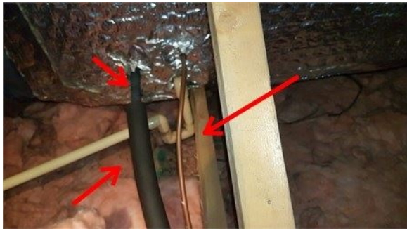
trace de condensation sur la laine, refaire l'isolant de la tuyauterie
