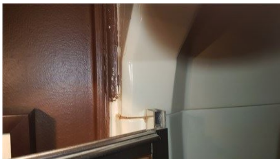
Lavabo rouillée , connection mal ajustée
