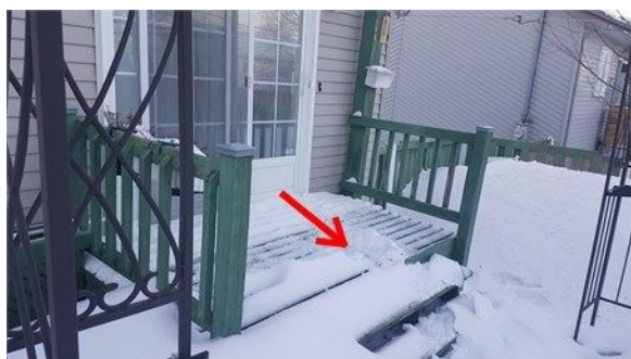
Attention lors de la réparation du balcon à remettre à niveau le balcon et dégager l'espace sous la porte patio
