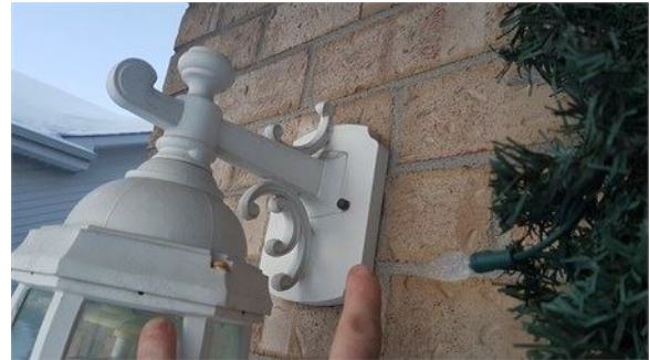
Ré-installer adéquatement l'appareil et rendre étanche
