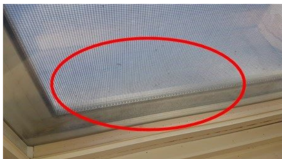
Fenêtre avec thermos décéder
