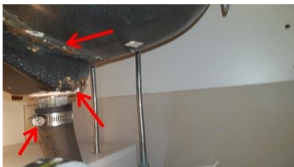
Lavabo rouillée , connection mal ajustée
