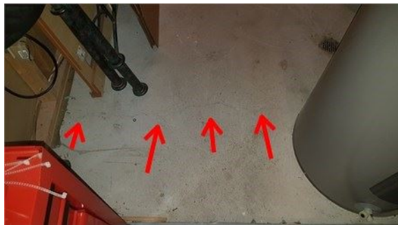
Petite fissure de retrait ( en surface)
