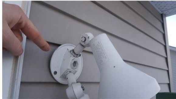
Ré-installer adéquatement l'appareil et rendre étanche
