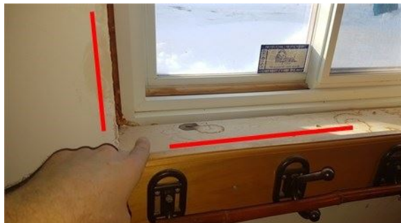
Fenêtre sous-sol, isolation à revoir
