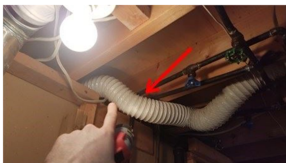
Conduit à remplacer
