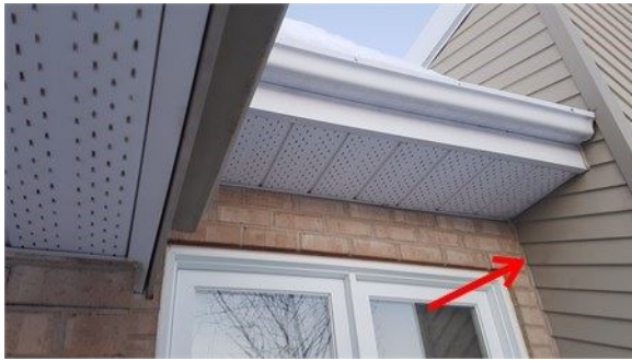
Scellant à la jonction des matériaux à refaire
