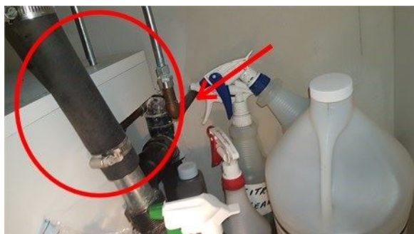
Tuyau à modifier installation non-conforme, ajouter des valves
