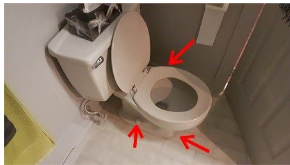
Solidifier la toilette, remplacer le beigne de cire sous la toilette avant de la re-solidifier
